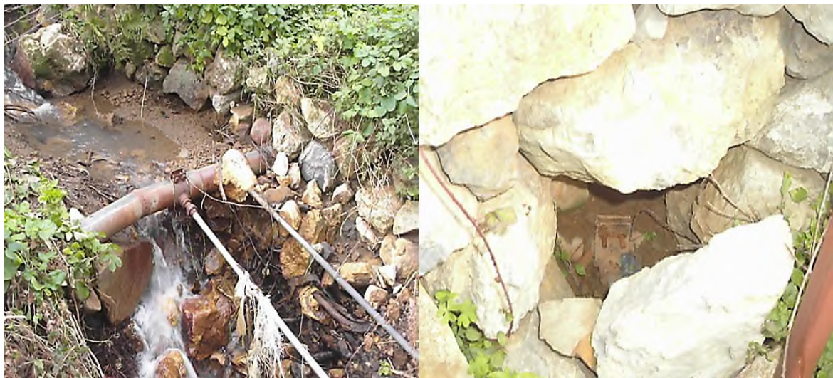
Figure.II.13 : Des branchements particuliers réaliser directement sur la conduite principale
