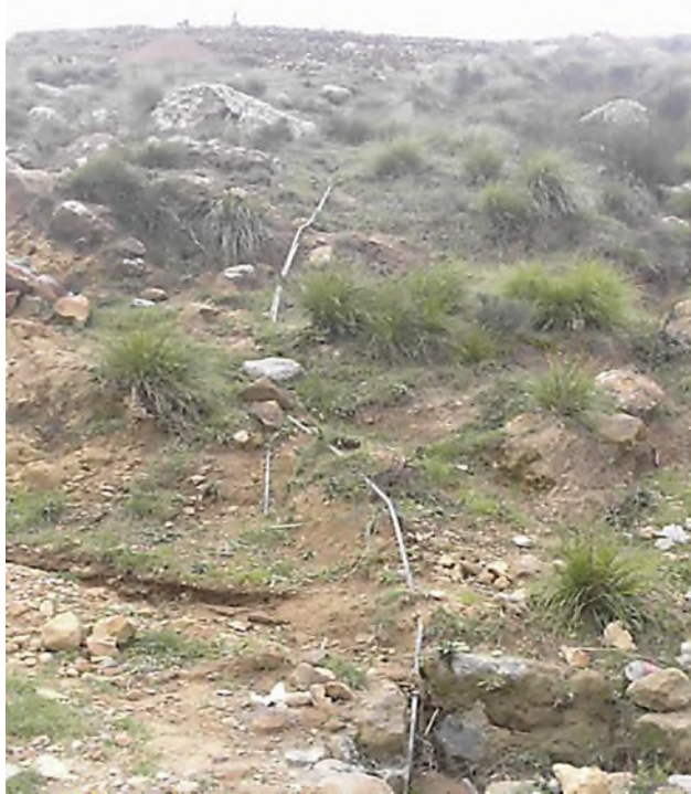
Figure.II.11 : Une conduite de distribution
