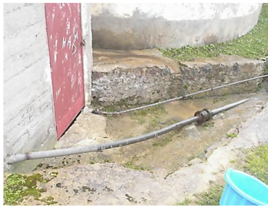
Figure.II.10 : Départ la conduite de refoulement à l'air libre et non protégée contre le phénomène du coup de bélier.
