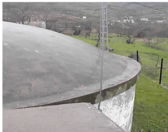
Figure.II.9 : Câble électrique qui frotte sur la coupole du réservoir 150m 3
