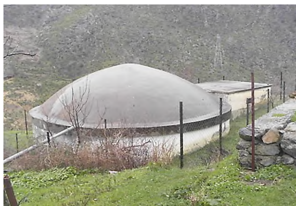
Figure.II.5 : L'extérieur du réservoir 150m 3
