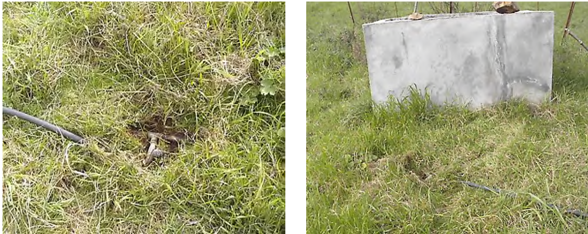
Figure.II.12 : Des piquages illicites directement dans des jardins répandus en plusieurs endroits
