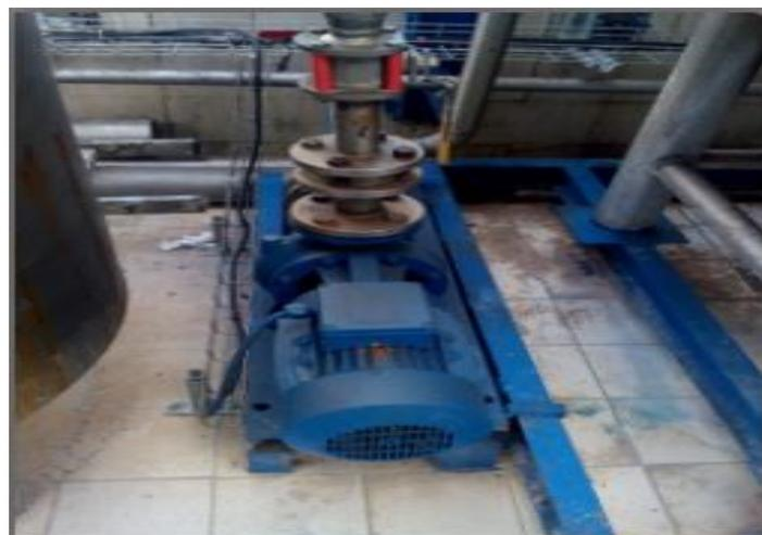
**Figure II.10 :** Aspect extérieur d'une pompe centrifuge.
