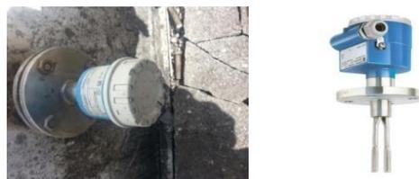
**Figure I.17** : Capteur de niveau.
