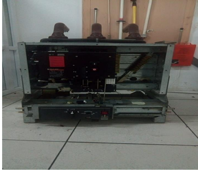
Figure1.7 : Disjoncteur SF débrochable
