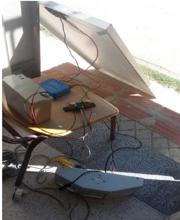
Figure IV.3 : Réalisation d'un éclairage public solaire à LED.
