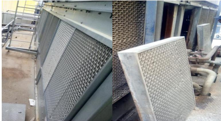
**Figure II.13** : Persienne d'entrée d'air
