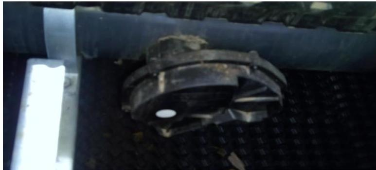
**Figure II.9 :** Système de dispersion du fluide à refroidir
