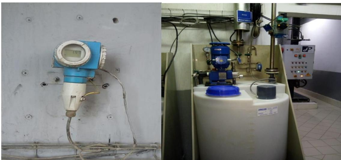
**Figure III.11:** Régulation de pH
