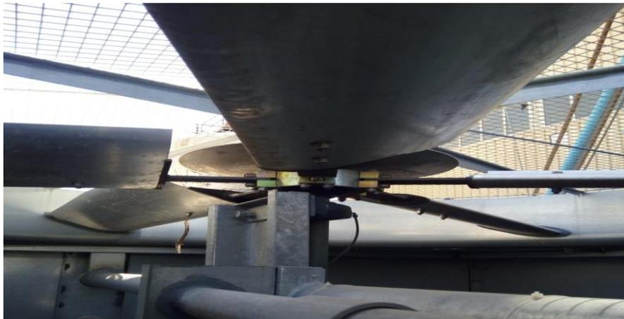
Figure II.11 : Ventilateur de la tour de refroidissement
