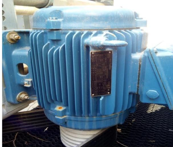
Figure II.15 : Moteur de ventilateur
