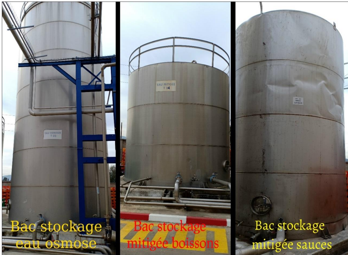
Figure (I.16) : Bac de stockage actuellement utilisées à CEVITAL
