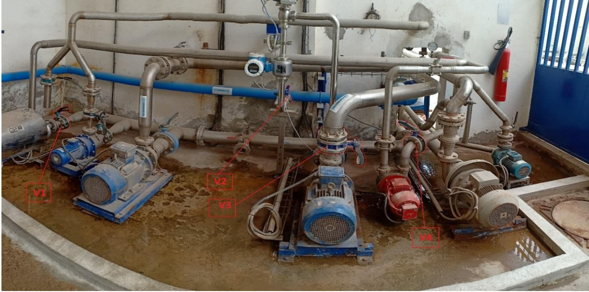
Figure (II.6) : Photo des vannes manuelles V1, V2, V3 et V4
