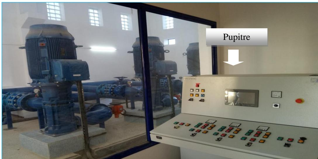
Figure II.10 : Vue de pupitre de commande
