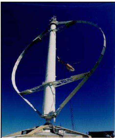
Éolienne de type Darrieus.
