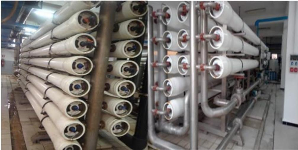
**Figure III.8** lignes d'osmose inverse de CEVITAL.
