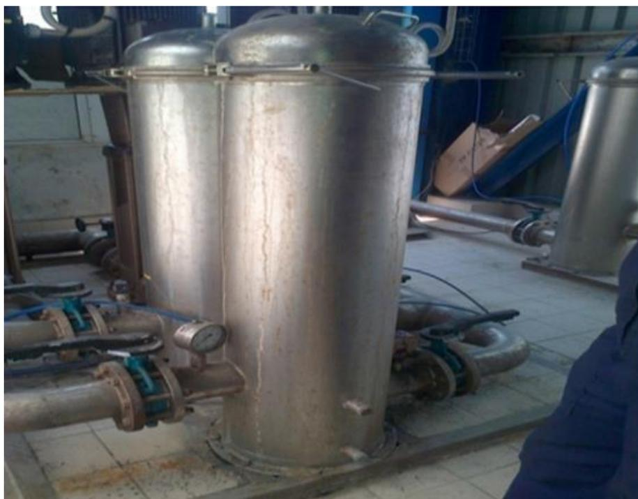
**Figure III.7** Face externe des filtres à cartouches utilisés au niveau de CEVITAL [57].
