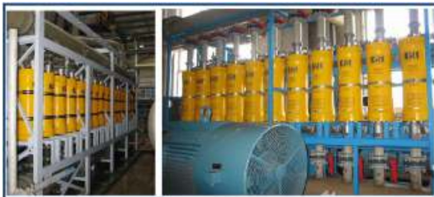
Figure III.10 : emplacement des échangeurs de pression.
