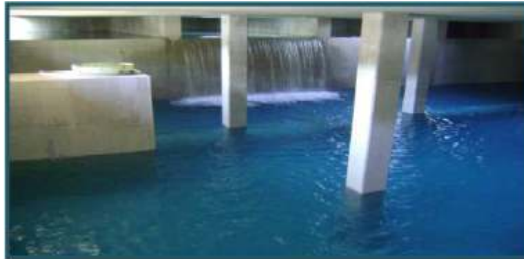
Figure III.14: Bâtiment de la saumure.
