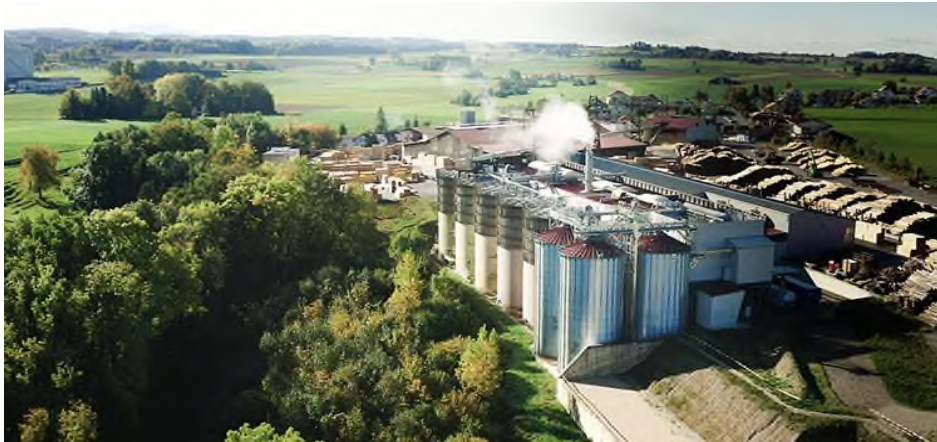
Figure I.5 : centrale de biomasse
