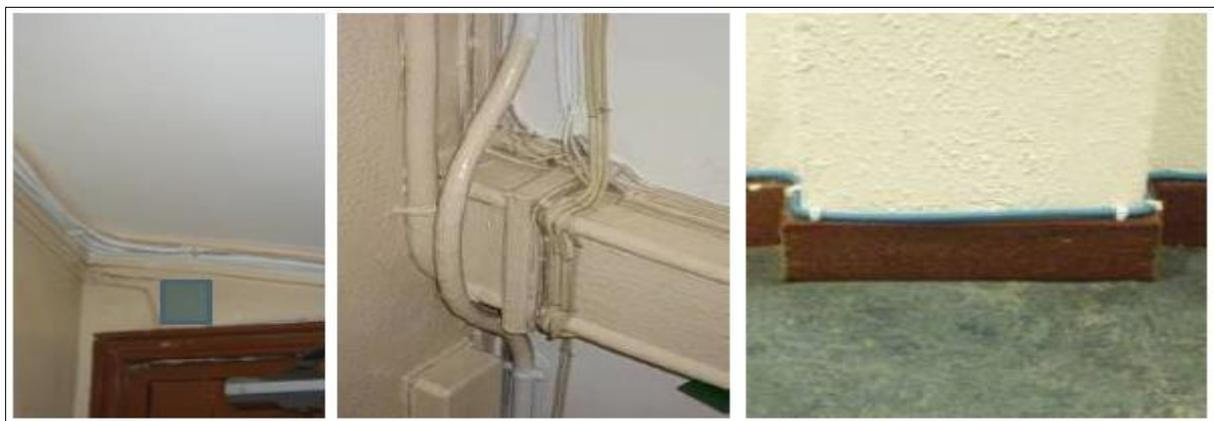
**Figure 2.** Exemples de cheminement de câbles à l'intérieur des bâtiments [63].
