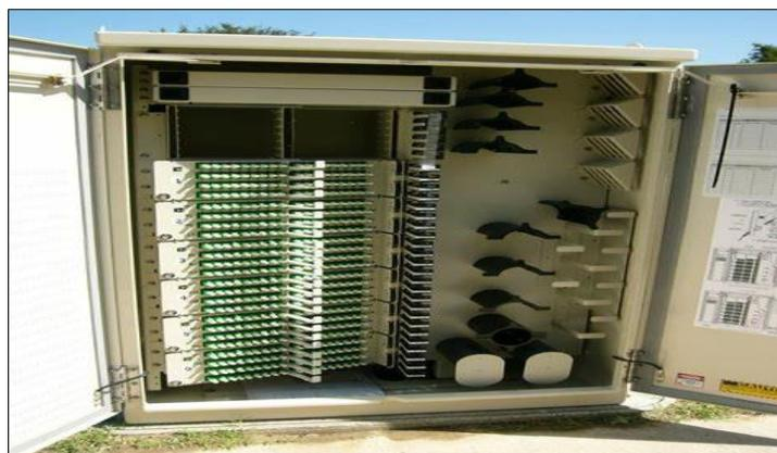
**Figure 9.** Boîtes de Distribution des Fibres FDT
