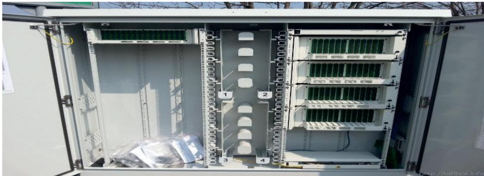
**Figure 7.** *Sous répartiteur optique SRO*
