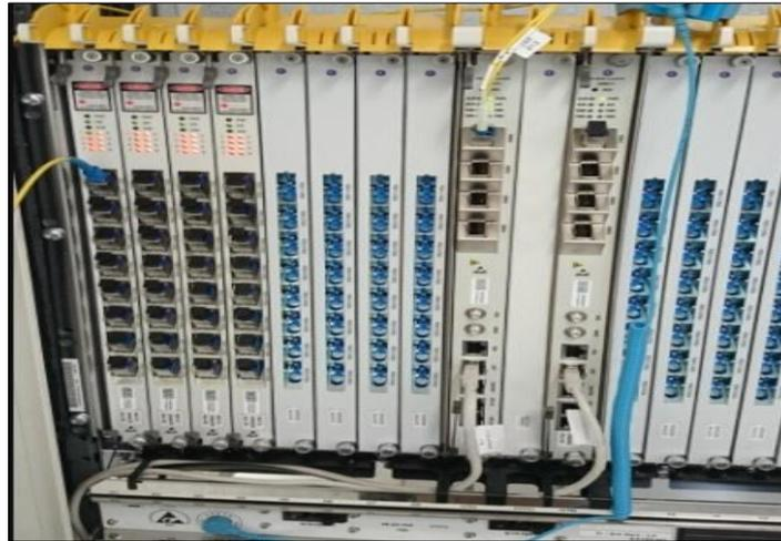
**Figure 4.** *Terminal de Ligne Optique OLT*
