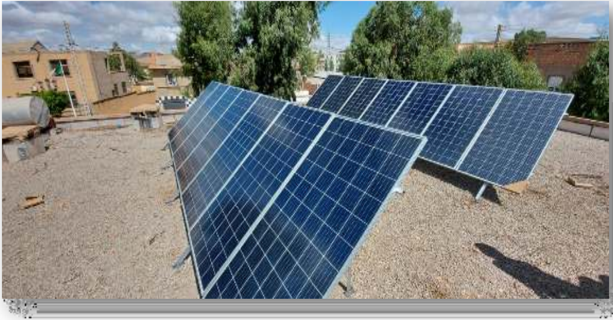
Figure.III.4 : Installation des panneaux sur la première structure (S1)
