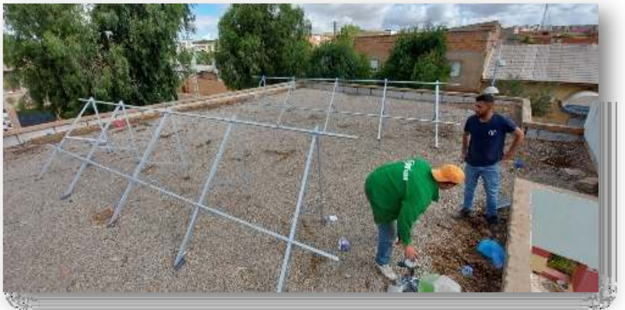
Figure.III.23 : Structure des panneaux photovoltaïques
