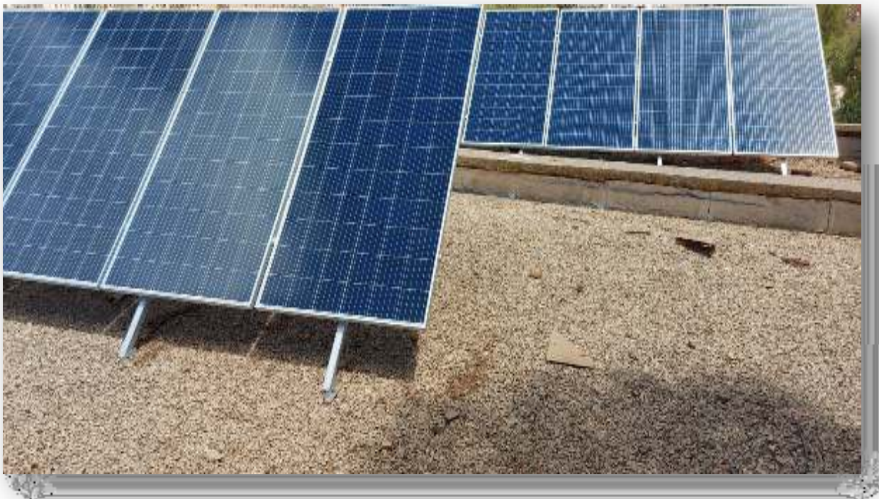
Figure.III.5 : Installation des panneaux sur la deuxième structure (S2)
