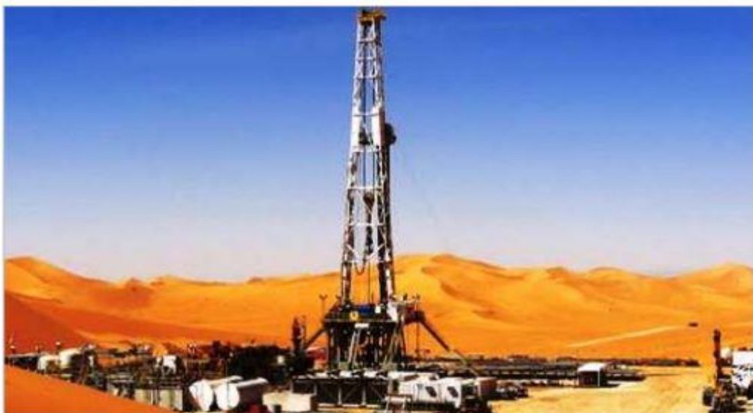
Figure I.4. Plateforme pétrolière Onshore.
