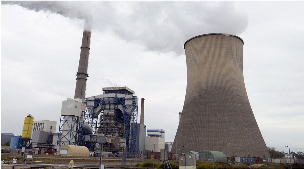
Figure I.2. Centrale à gaz.
