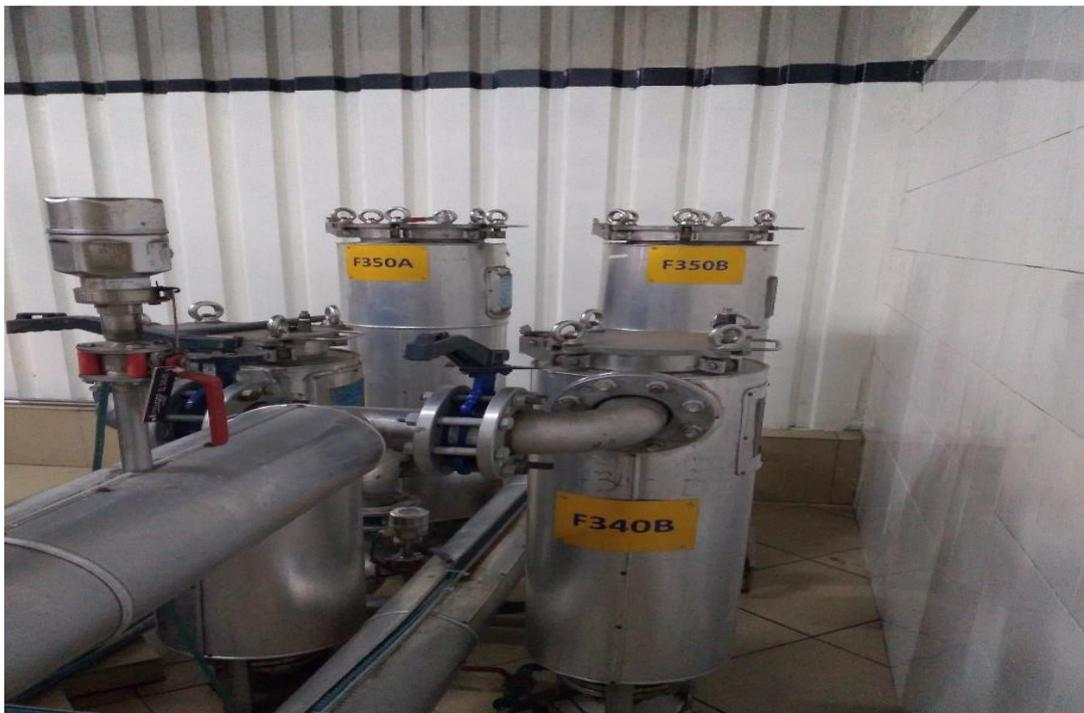
**Figure II.5 :** image réelle de filtre à poche (F340) et filtre à cartouche (F350)
