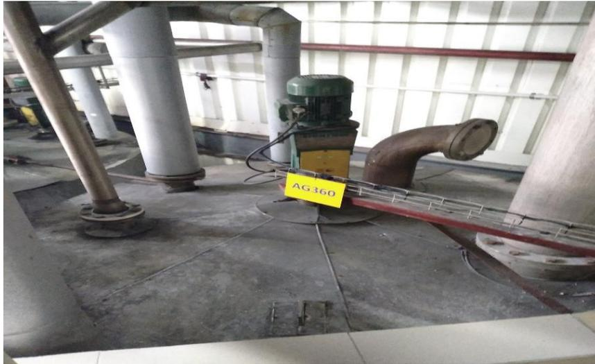
**Figure II.2 :** image réelle d'agitateur (AG360).
