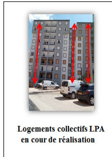
Figure 69: Façade des logements LPA en cour de réalisation
