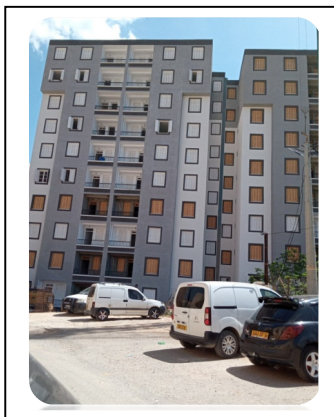
Figure 56: Façade urbaine Sud
