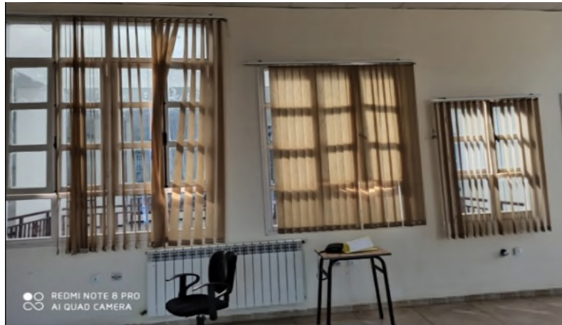
Figure 4.11 : vue intérieure sur les fenêtres en bois,(source: auteures,2021).
