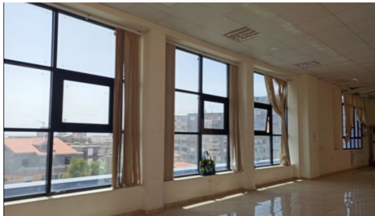
Figure 4.10: vue intérieure sur le mur rideau (source : auteurs, 2021).
