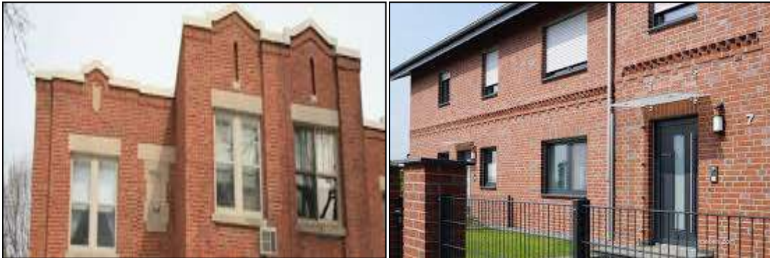
Figure 15: la façade en brique.
