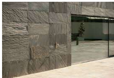
Façade ventilée en pierre
