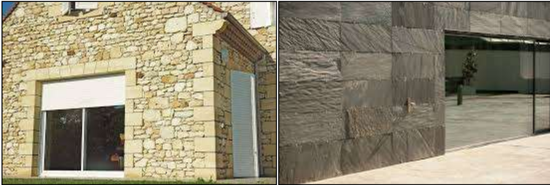
Figure 14: la façade en pierre
