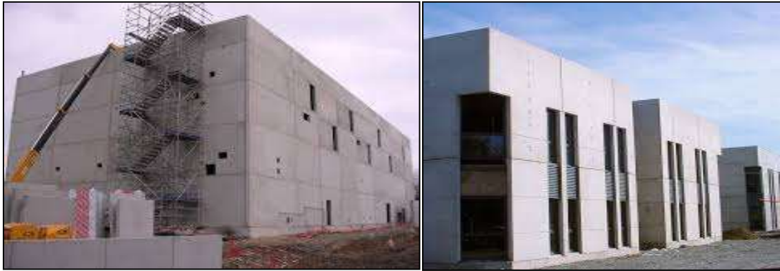
Figure 16: la façade en béton armé.
