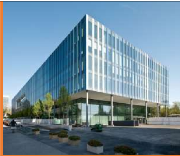
Figure : vue sur le bâtiment
