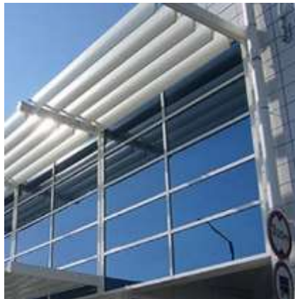
Figure 01 : les avancées extensibles.
