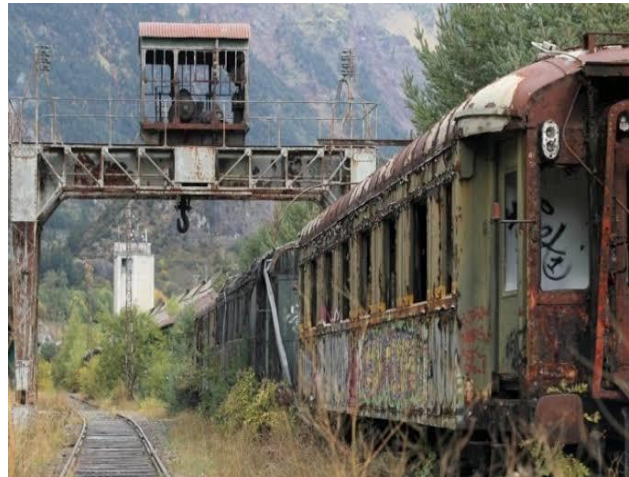
Figure 5: Friches ferroviaires, Gare monumentale de canfranc en Espagne source : la république des pyrenees.fr
