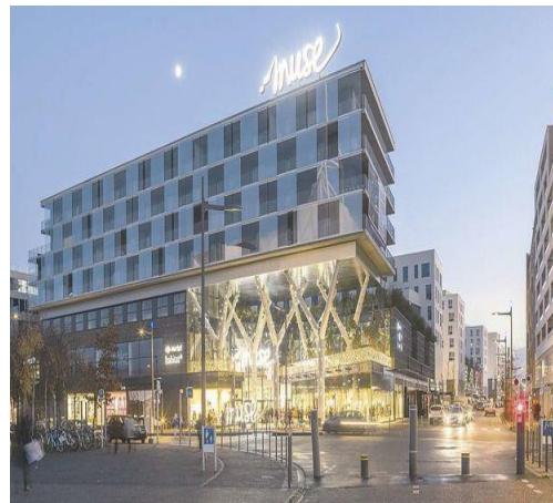
Figure 50: Equipement culturel, exprime la Perméabilité Physique comme élément de rappel ou un point de repère, Source google image
