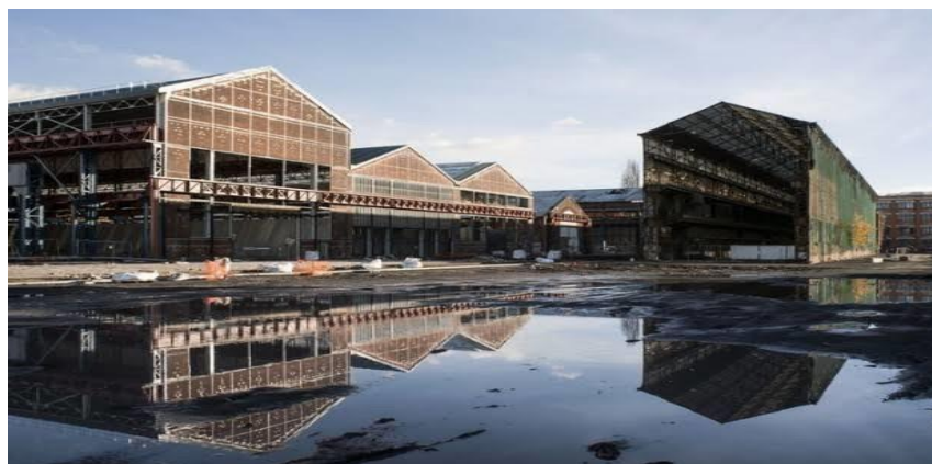
Figure 8 : Vu sur une friche industrielle à Lille en France source : Projet pour réhabiliter un ancien hall industriel
