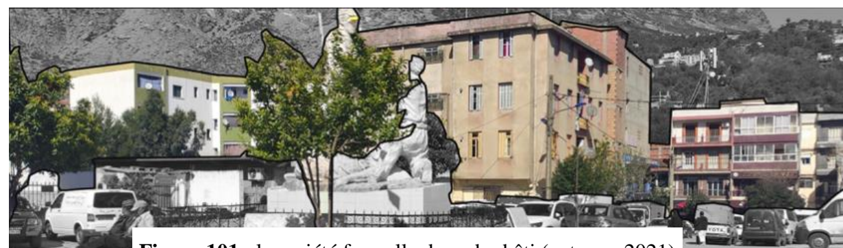
Figure 101 : la variété formelle du cadre bâti (auteure, 2021)
