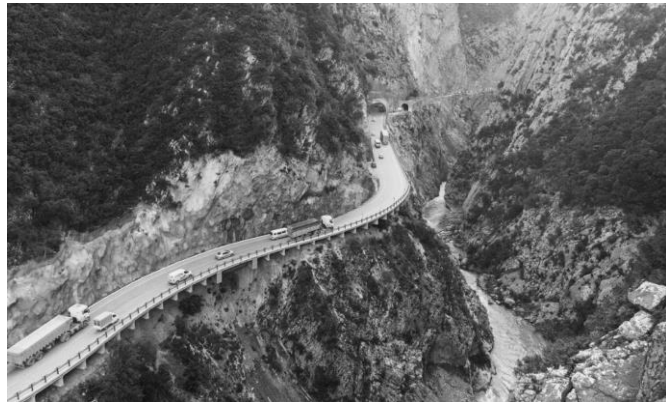
Figure 73: tronçon livré de projet de modernisation de la RN09
