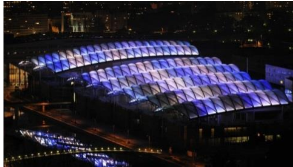
Figure 143: vu sur La toiture en ETFE du centre commercial et de loisir de Confluence de Lyon
