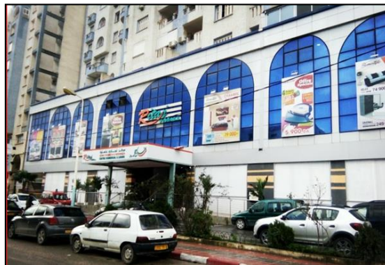
Figure 40: la façade principale de centre commercial Ritaj Mall Source : photos prise par auteur le 02/06/2021
