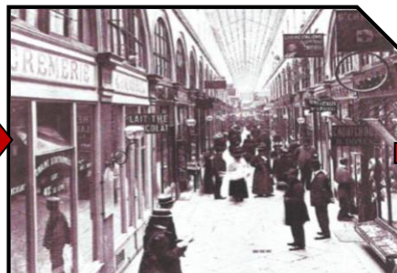
Figure 25: halle et pavillon Source : www.transit-city.com
