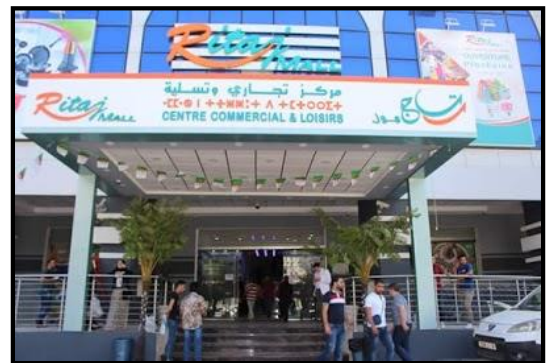
Figure 34: centre commercial ritaj mall Source : auteur
