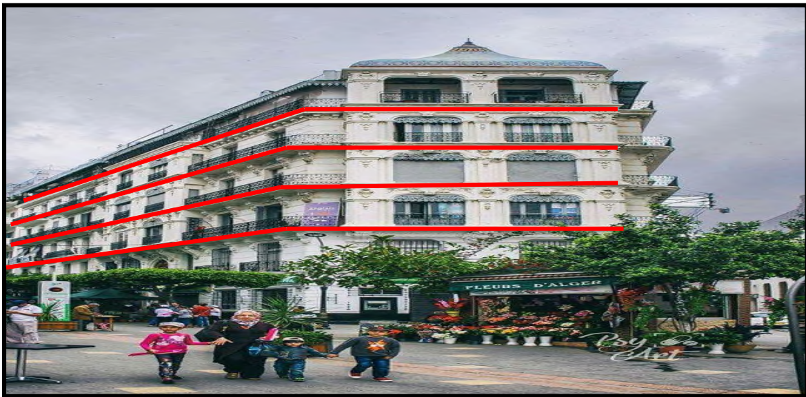
Figure 44: Image illustrant les rythmes horizontaux sur un immeuble colonial à Alger
