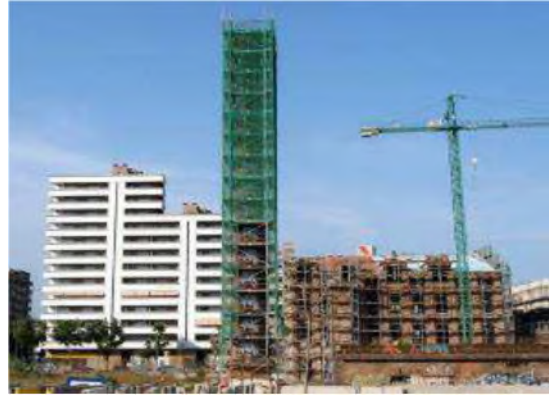
Figure 60: Protection du patrimoine au quartier 22@ Barcelone
