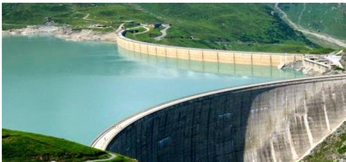
Figure 2 – le barrage d'Ighil Emda
