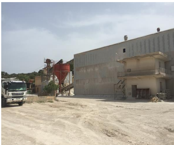
Figure II.1 : l'unité de traitement
