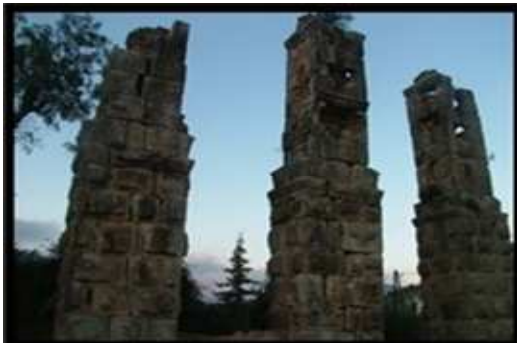
Photo n°13: Aqueduc de Toudja
