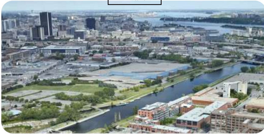
Fig40 : centre du tri postal du 1500 rue Ottawa Source : (GoupeCardinalHardy, 2009).
