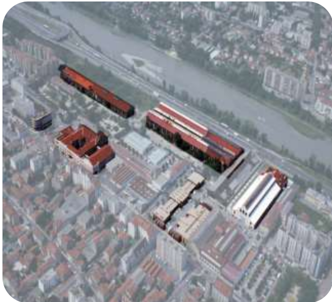
Fig04 : l'ancien site industriel de bouchayer Source : Google image
