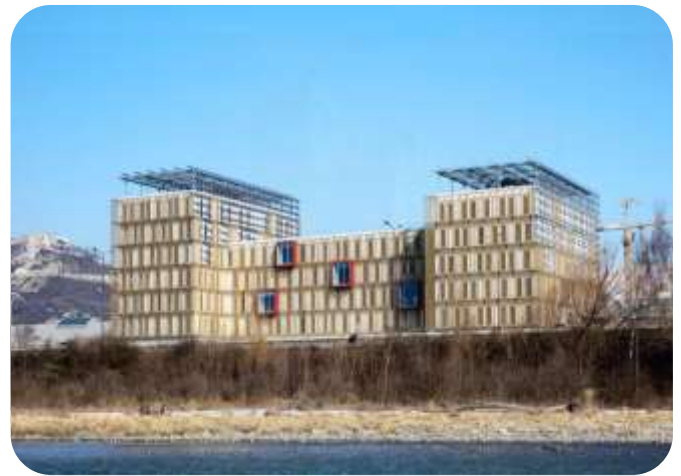
Fig14: bâtiment à basse consommations énergétique
