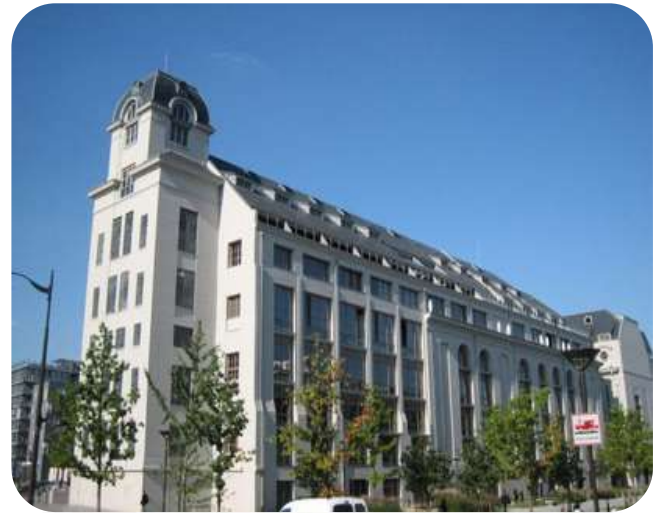
Fig27 : Les Grands Moulins réhabilités pour les nouveaux locaux de l'université. Paris7.
