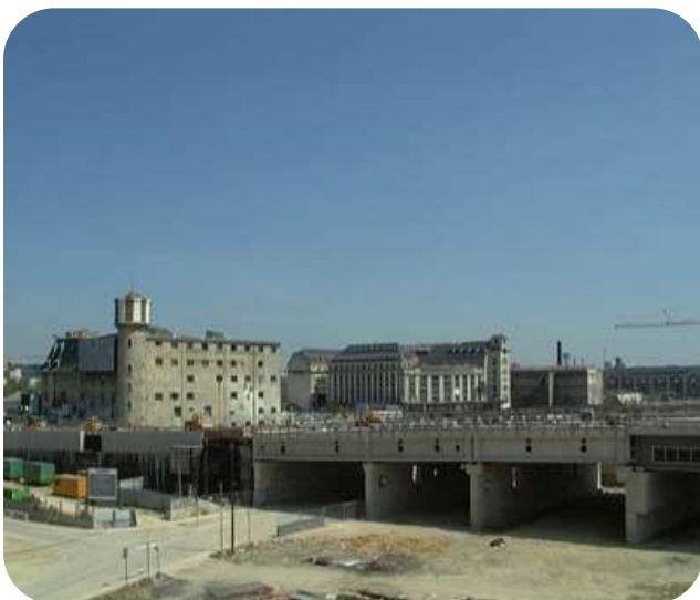
Fig28 : chambre froide de paris rive gauche. Source : (PALYTIME, 2008).
