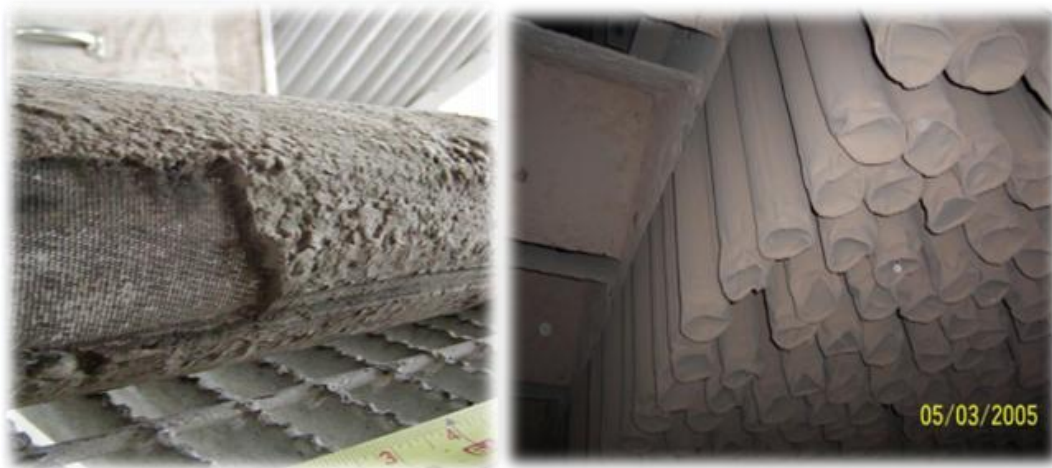
Figure I-3: Les poussières collectées sur les manches forment un "gâteau "[10]
