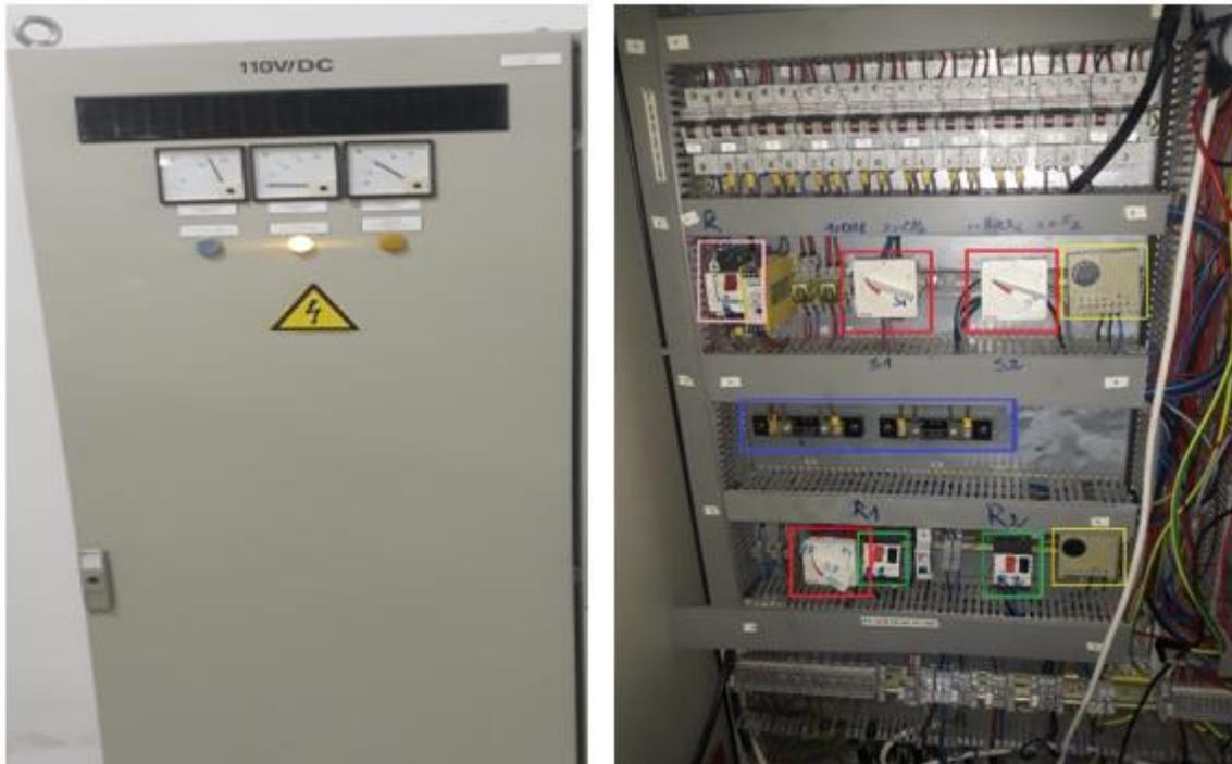
**Figure I.3 :** L'armoire 110 VDC.
