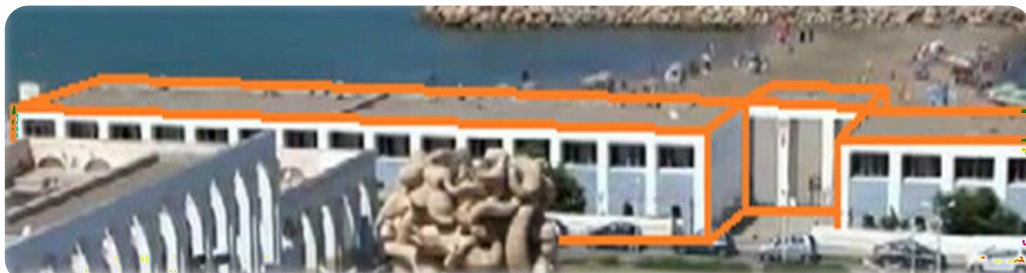
Figure 63 façade de l'hôtel montrant sa composition volumétrique
