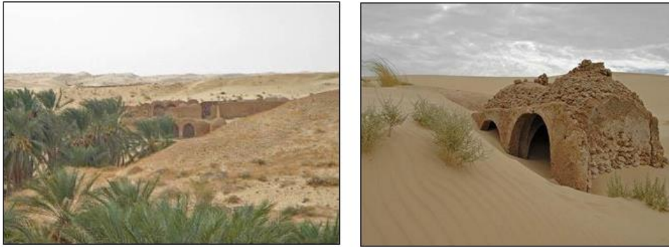
Figure 36 La maison traditionnelle du Souf. Source : http://algeriadz.com
