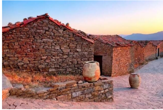
Figure 38 Maison traditionnelle kabyle. Source : site web http://www.mcmto.dz/ .
