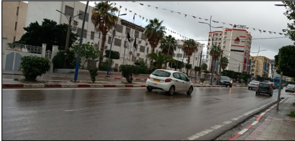
Figure 95 : Immeuble administratif répondant favorablement à la justesse visuelle, source : photo prise le 11/12/2021
