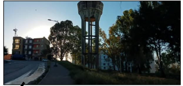
Figure 70 Château d'eau délaissé à l'intérieur du terrain, source: Photo prise le 02/01/2022
