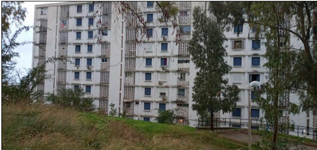
Figure 94 : Immeuble collectif non modifié, source : photo prise le 11/12/2021
