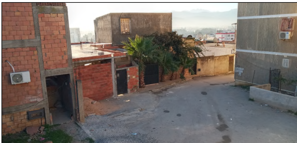
Figure 96 : Façade d'habitation individuelle non achevée, source : photo prise le 02/01/2022
