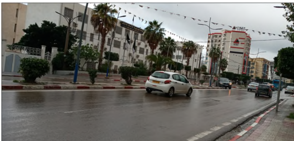
Figure 93 : Zone d'immeubles administratifs, source : photo prise le 11/12/2021
