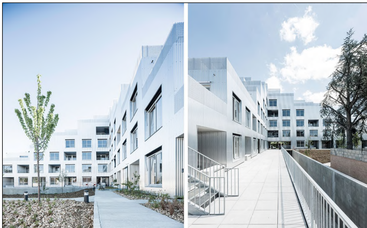
Figure 19 et 20 : Photographies du bâtiment Unité(s), source : sophie-delhay-architecte.fr
