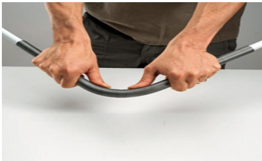
Figure I. 16: Cintrage à la main [11]
