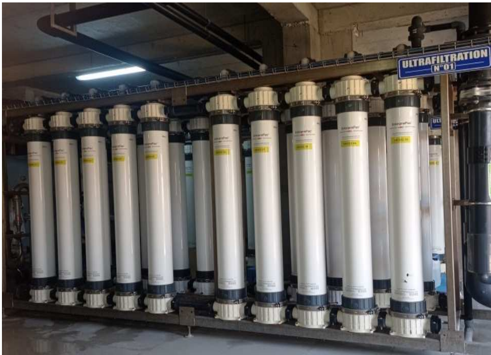
Figure III.6 : Modules d'ultrafiltration.
