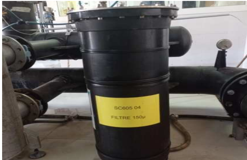
Figure III.4 : Carter du filtre à poche.
