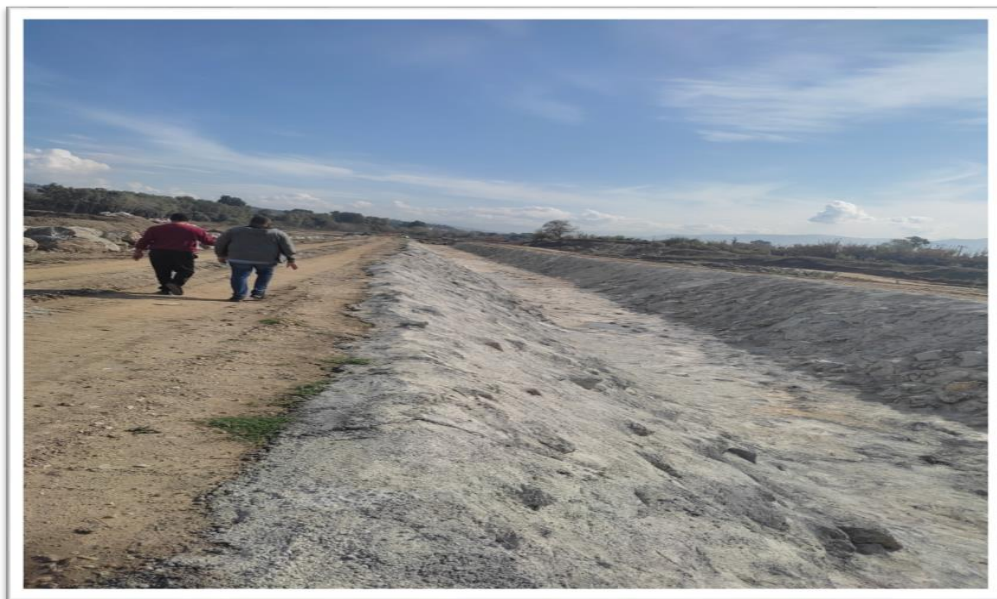
Figure IV.2: Représente les images de la digue en gabion en cours de réalisation prises sur chantier.
