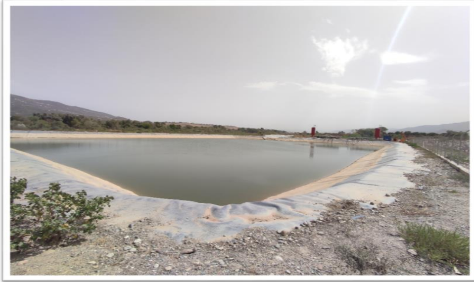
Figure IV.4: Image du bassin de décantation prise sur chantier.
