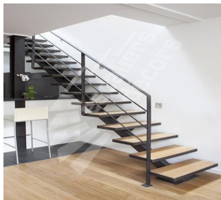
Figure 13. Exemple d'escalier en charpente métallique
