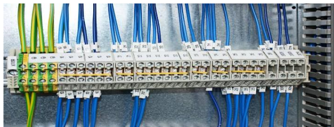
Figure III. 22 : Répartiteur électrique
