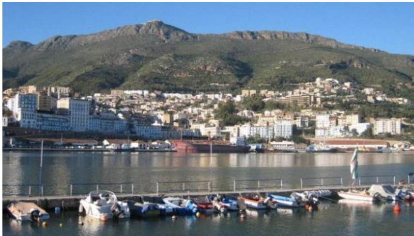
Figure IV.13 Port de pêche de Bejaia sans éclairage ni source d'énergie pour les pêcheurs
