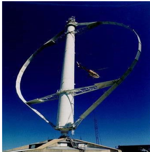
Figure I.2 :Eolienne à axe vertical [14].
