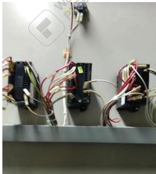
Figure I.2 : Régulateur électronique KS90-1
