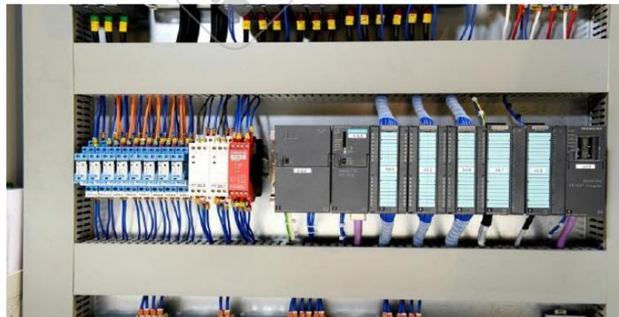
Figure II.6 : Automate programmable de type modulaire (siemens)
