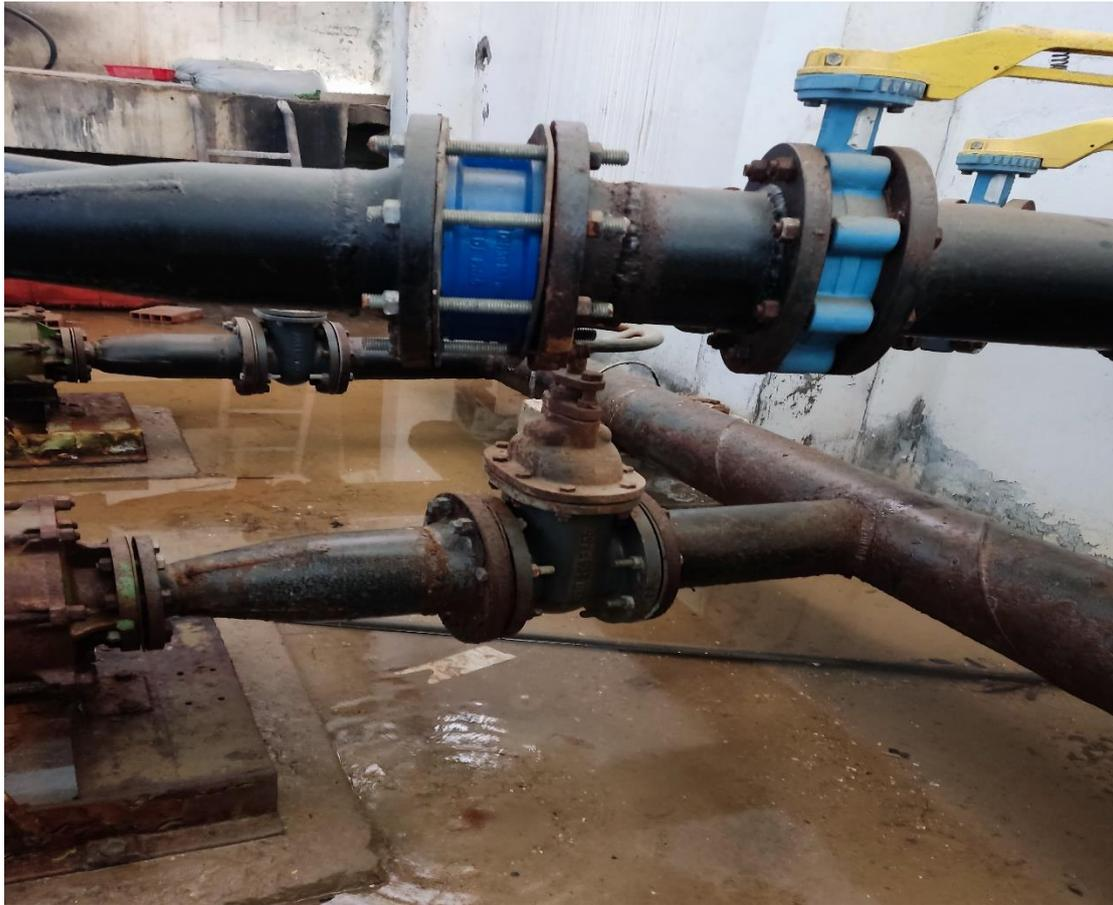
**Figure II.5.** Fuite visible dans la vanne de la conduite d'aspiration
