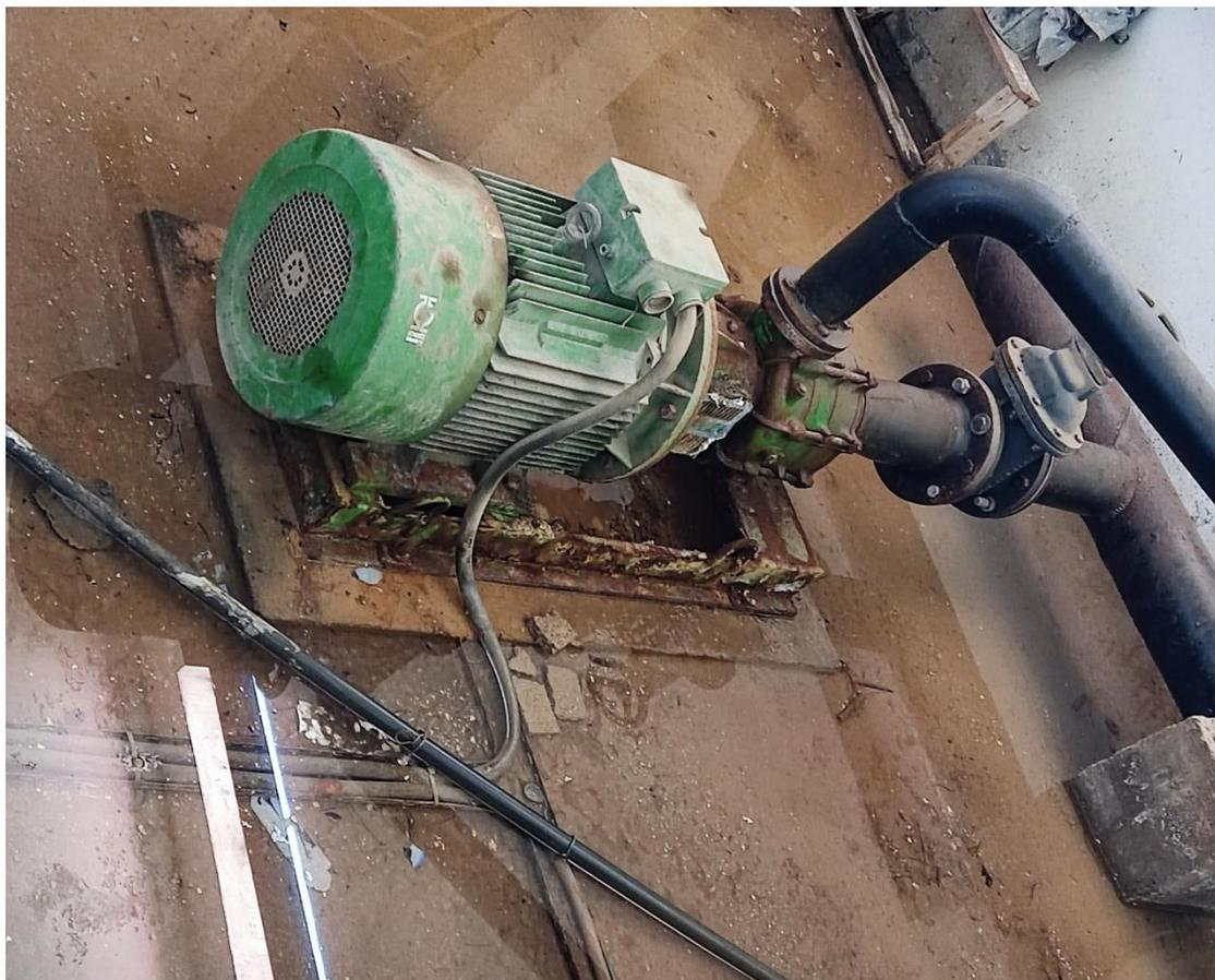
Figure II.8. Détérioration de l'état extérieur des pompes
