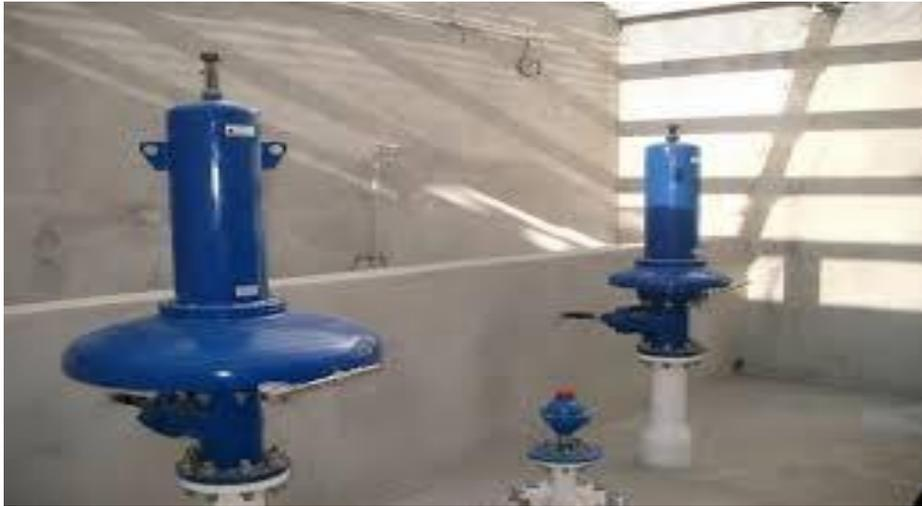
Figure VII.1. : soupape de décharge
