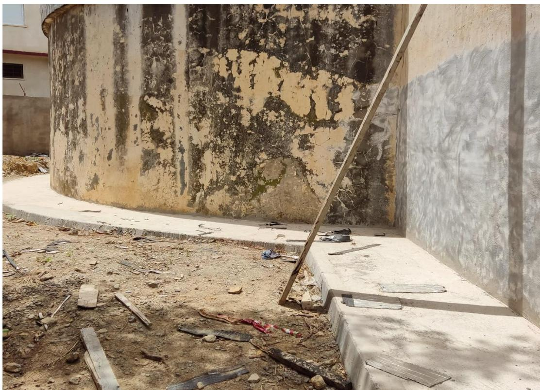
**Figure II.2.** La peinture des parois du réservoir en mauvais état
