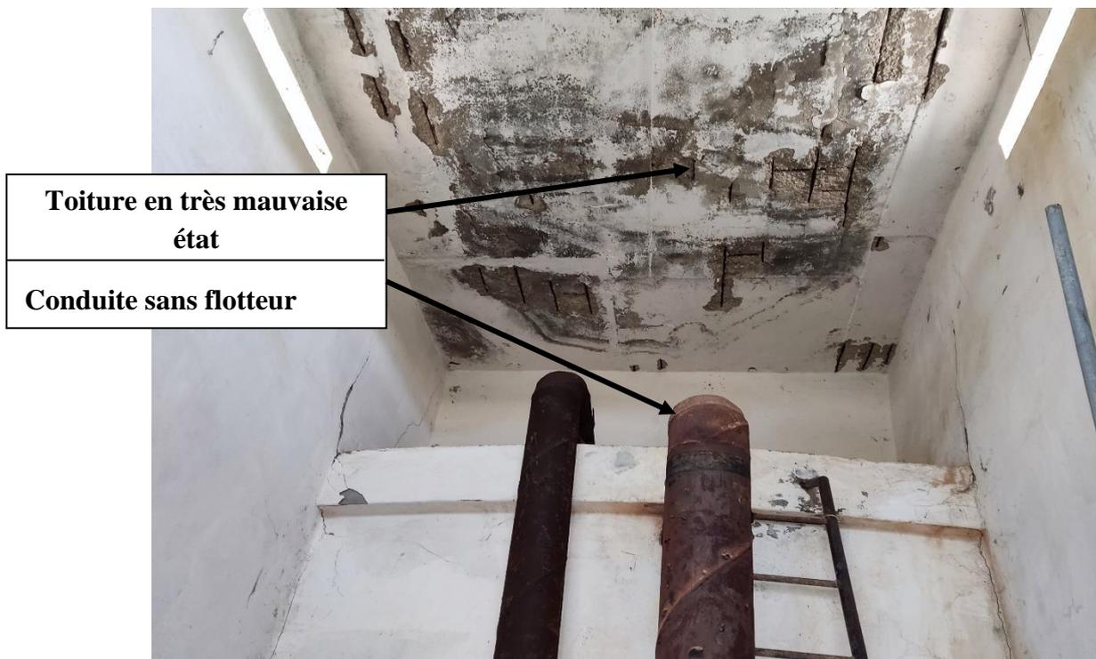
**Figure II.10.** Etat de l'intérieur de la chambre des vannes
