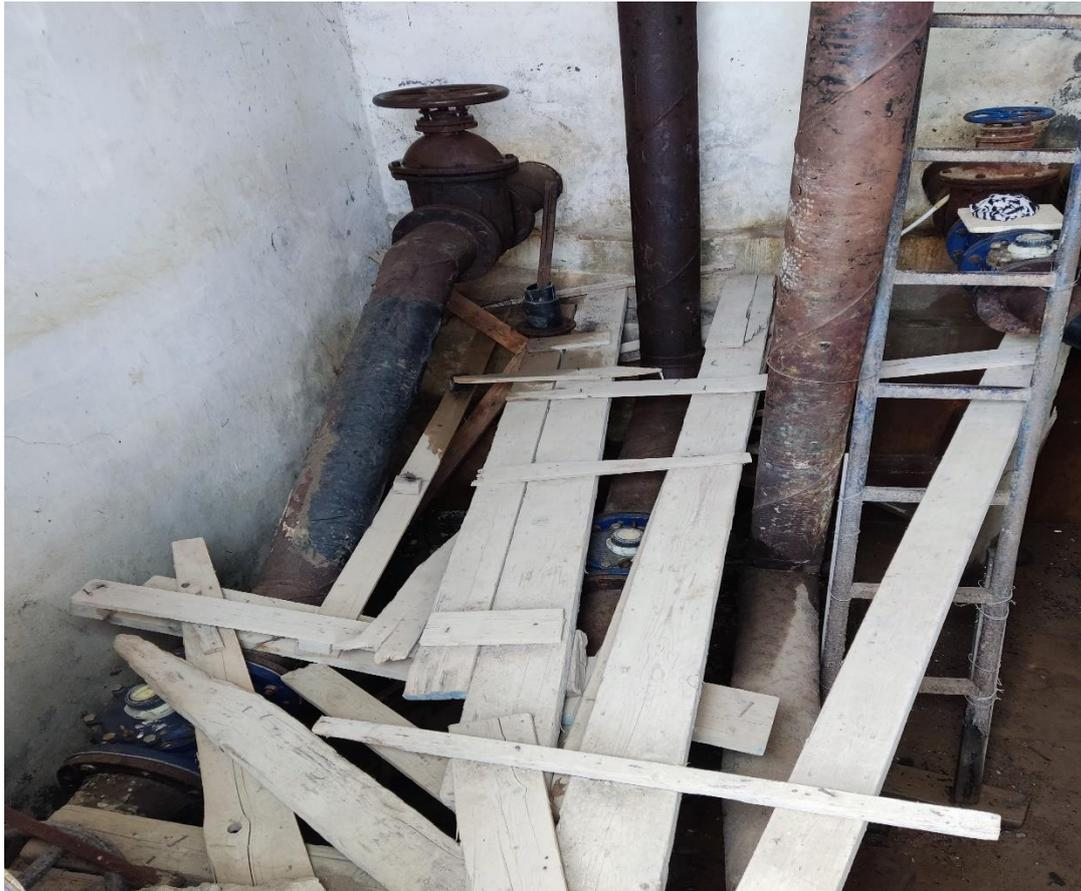
**Figure II.9.** Etat de la chambre des vannes : utilisation de planches en bois comme passerelle
