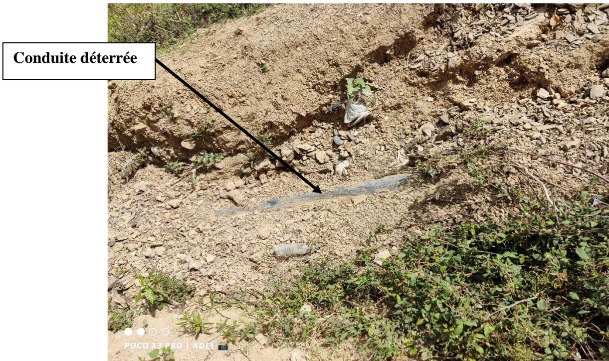
**Figure II.11.** Déterrement de la conduite de distribution
