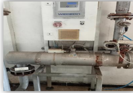
Figure 15. Photo représentant le générateur et module UV
