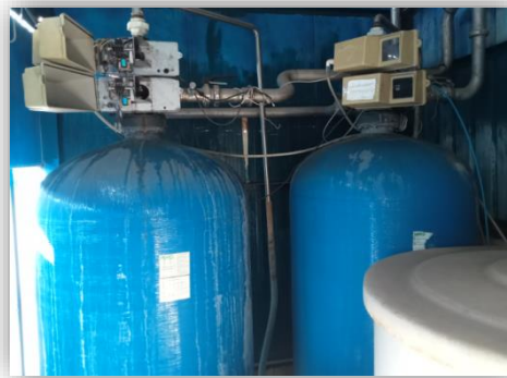
Figure 16. Photo représentant les deux Adoucisseurs
