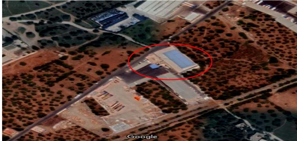
Figure 4. Situation géographique de l'entreprise Ait Brahem Mouhend Ouzellaguene Bejaia (Google Maps).
