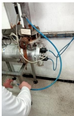
Figure 5. Photo représentant le prélèvement de l'eau de process de l'appareil ultra-violet (cliché Ouddak & Ghebrioua, 2023).
