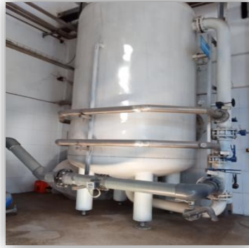
Figure 13. Photo représentant filtre à sable
