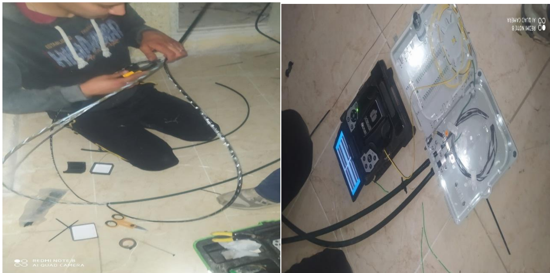
Figure 2-33: raccordement de câble au niveau de PBO
