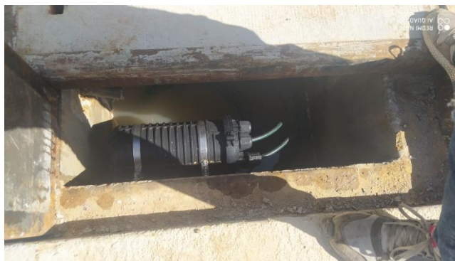
Figure 2-16.: Représentation d'un BPE souterrain
