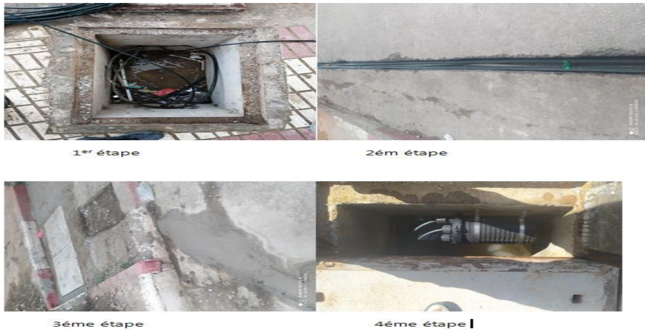
Figure 2-30 : : les étapes d'installation de fibre souterraine
