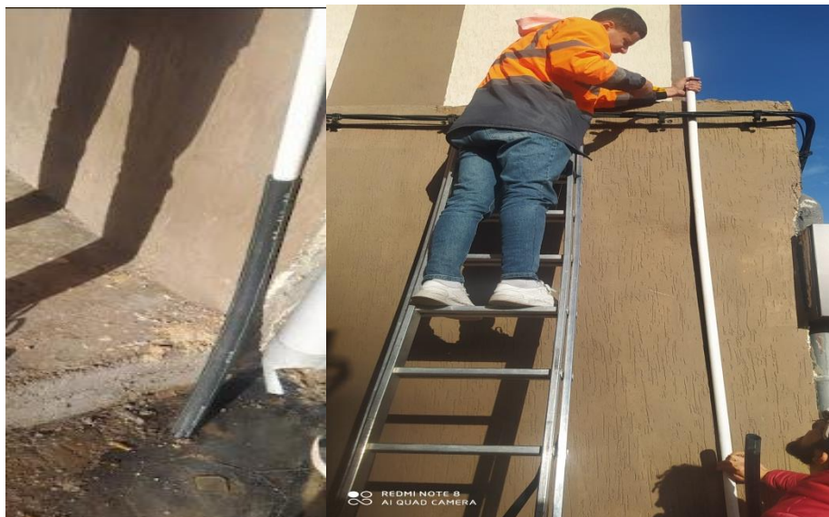
Figure 2-31: acheminer le câble a l'intérieur de PVC
