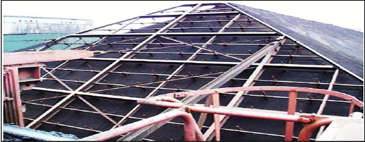
Figure I.5 : La machine Herze servant à homogénéiser les différentes couches [13].
