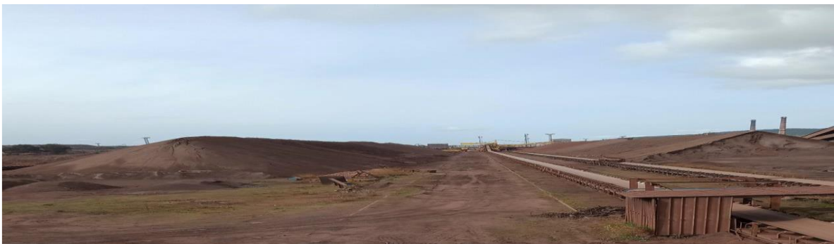
Figure I.4 : Mise en tas
