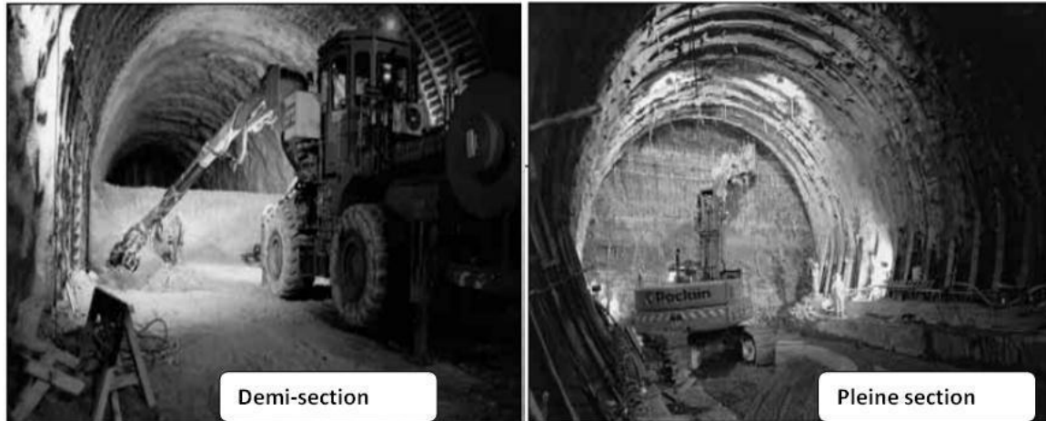
Figure I. 15 Images d'excavations par pleine et demi section. [18]
