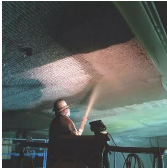
Figure I.21 Soutènement par béton projeté. [25]
