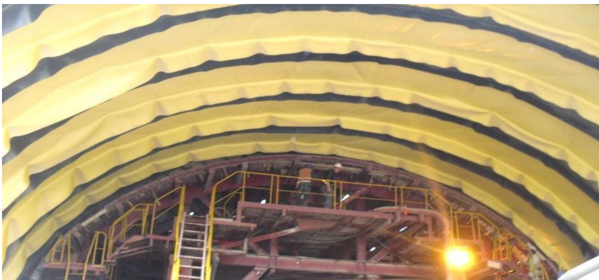
Figure I. 23 Mise en place du dispositif d'étanchéité. [23]
