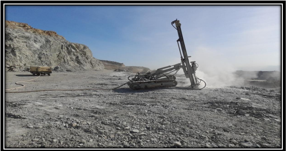
Figure 6. Opération de foration
