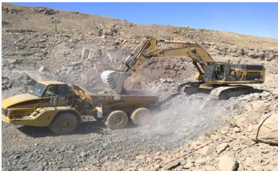
Figure II.4: Chargement à l'aide d'une pelle et le transport. [14]
