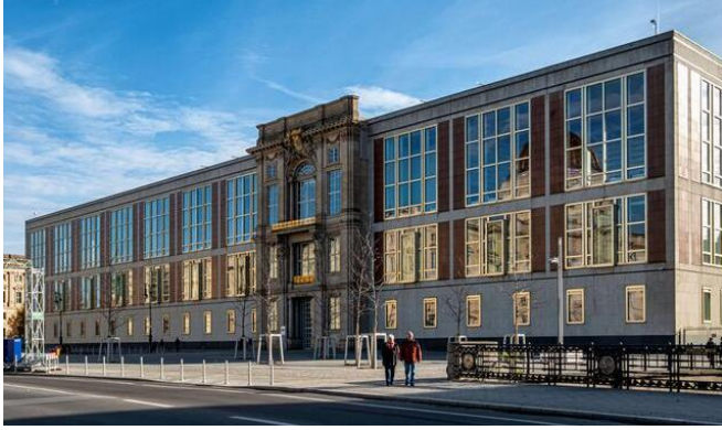
Figure 3 : Entrée de l'ancien palais de Berlin et du nouveau bâtiment du Conseil d'État de Berlin-Est. Source : www.Alamy.com.
