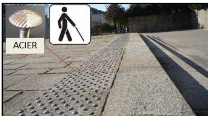
Figure 126: type de dispositif podotactile à utiliser.
