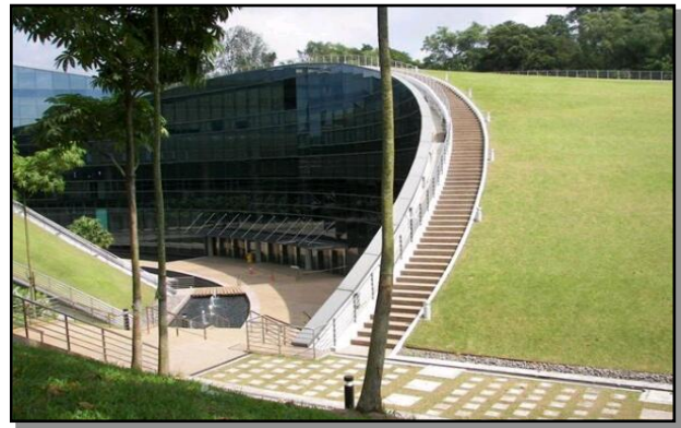
Figure 21 :la toiture de l'université de Singapour (businessinsider.com.pl, 2013)
