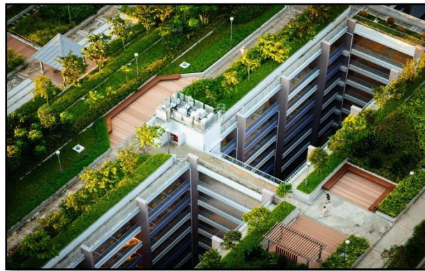
Figure 4 : la toiture végétalisée (chuttersnap,2023)
