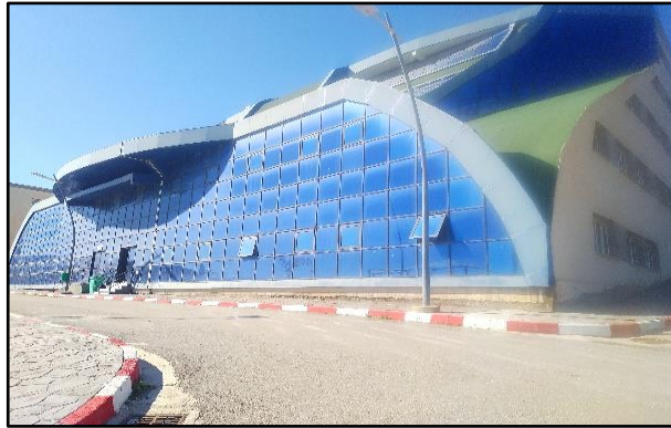
Figure50 : la représentation des murs rideau dans la bibliothèque (Auteur,2023)
