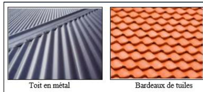
Figure 28 : Exemple de matériau de toiture incombustible
