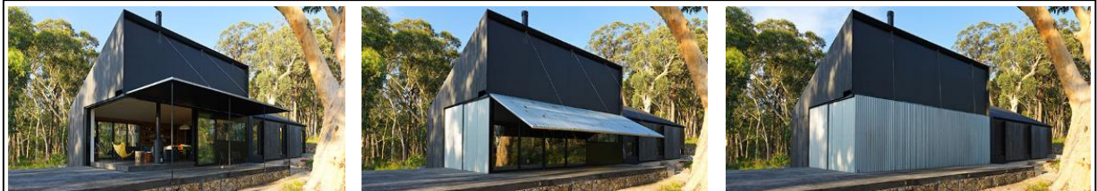
Figure 54 : Le mur latéral transformable en véranda
