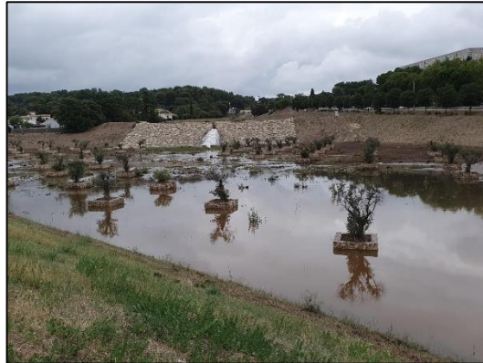
Figure 25 : Bassin de rétention servant d'interface aménagée- Nîmes
