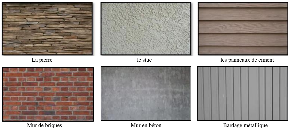
Figure 42 : certains des nombreux matériaux naturels et fabriqués pour le revêtement de maison résistant aux incendies. Source : (Service d'incendie de Colorado Springs, 2022)
