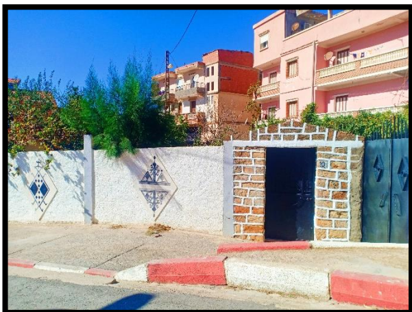
Figure 87 : habitations individuelle Source : (Prise par l'auteur, 2023)
