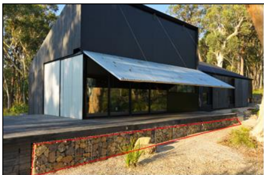
Figure 56 : mur de gabions en pierre le dessous de la maison
