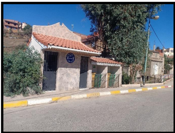
Figure 86 : Sanitaire public Source : (Prise par l'auteur, 2023)
