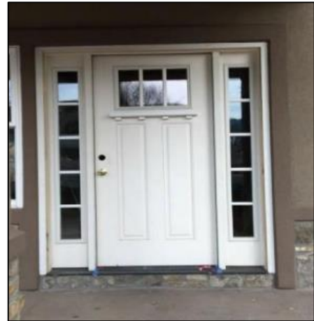
Figure 45 : Exemple d'une porte d'entrée approuvée avec verre trempé. Source (Service d'incendie de Colorado Springs, 2022)
