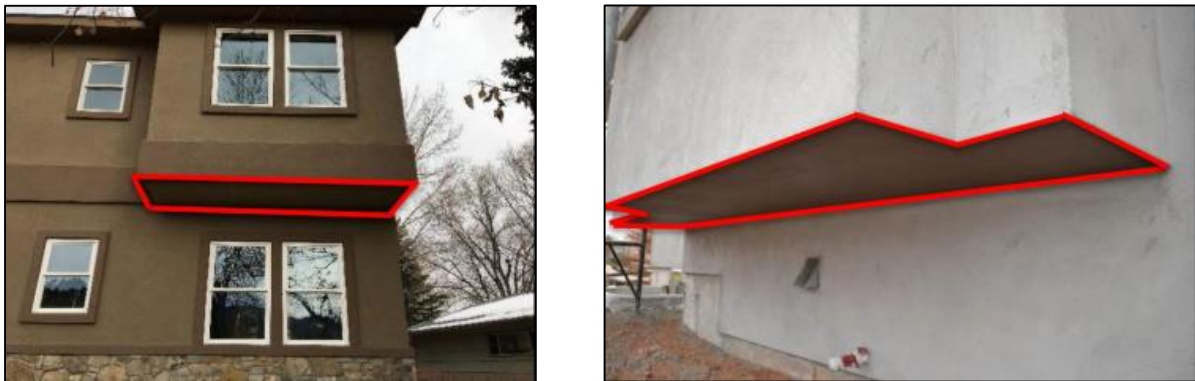
Figure 43 : Les lignes rouges représentent les zones qui devraient être construites avec des matériaux résistants à l'inflammation
